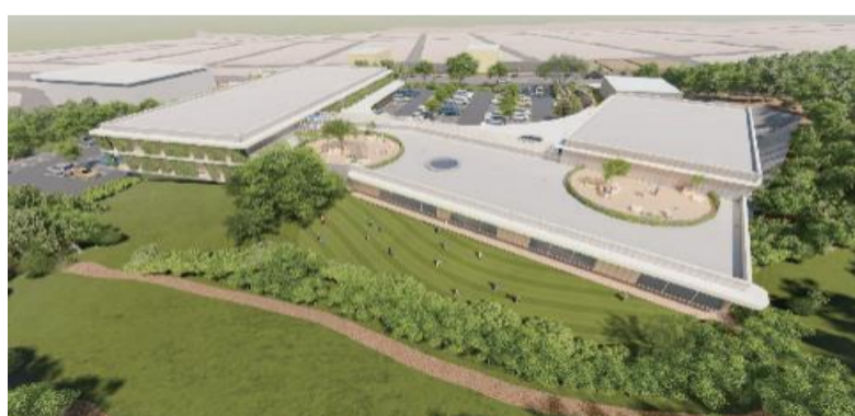
多世代共生型施設（仮称）福祉ヴィレッジ外観イメージ
