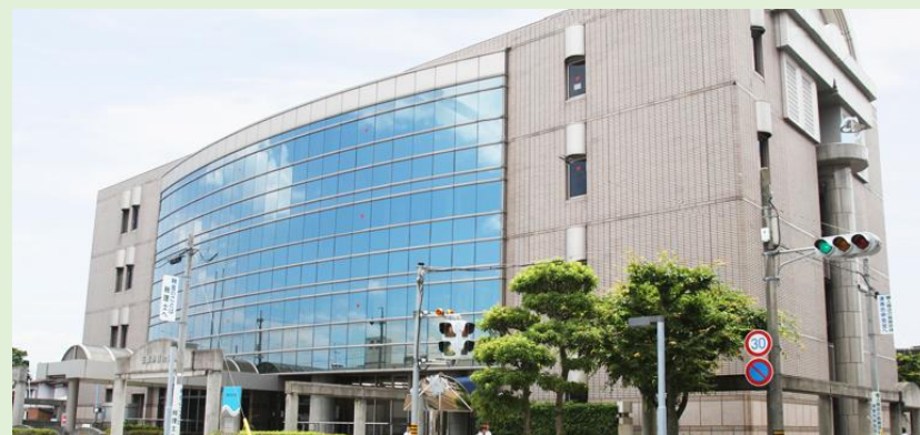
三重県自治会館
